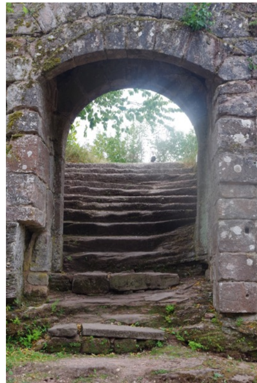
L'escalier escarpé vers le paradis EOSC, Château du Grand-Geroldseck
